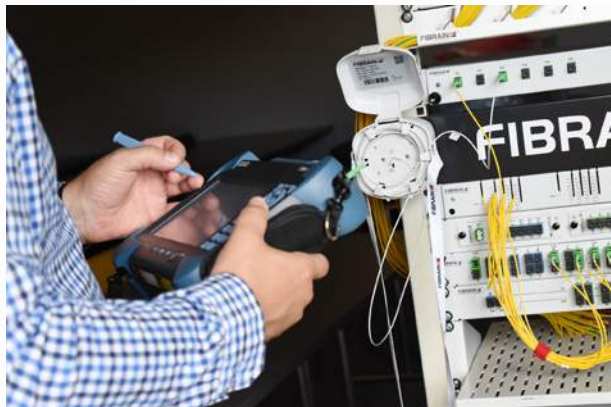
Zdj. 1. Mocowanie rozbiegówki FIBRAIN OSC na magnes na obudowie szafy światowodowej
