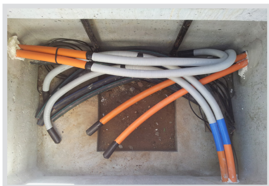
Przed wykonaniem złączy
