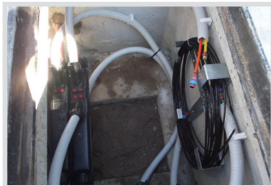
Wyprowadzenie mikrokabli na stelaż zapasu
