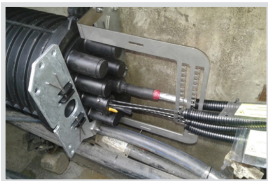
Przykład wprowadzenia mikrokanalizacji do szafy kablowej
