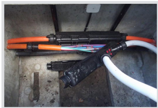
Widok złącza mikrokanalizacji
