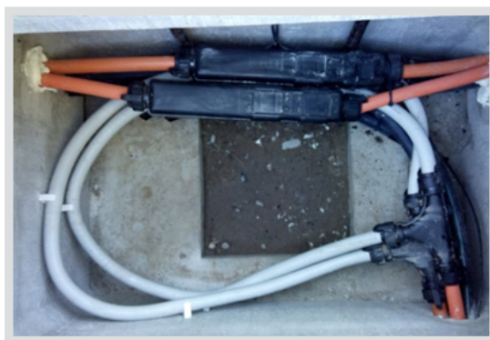
Po wykonaniem złączy
